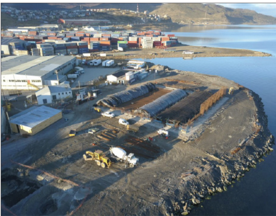
La obra de la nueva planta cloacal de Arroyo Grande, en la ciudad de Ushuaia.
