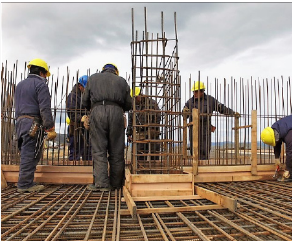
Esta nueva planta resolverá la falta de tratamiento de los efluentes cloacales domiciliarios de la Margen Sur de Río Grande, que a la fecha son volcados en crudo al mar o al río.
