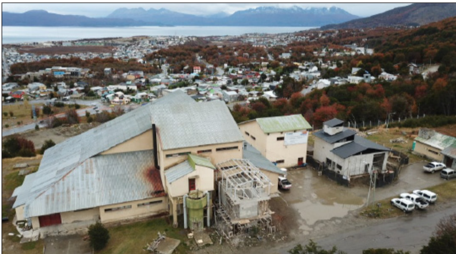
La Planta Potabilizadora N° 2, uno de los establecimientos que está siendo modernizado.
