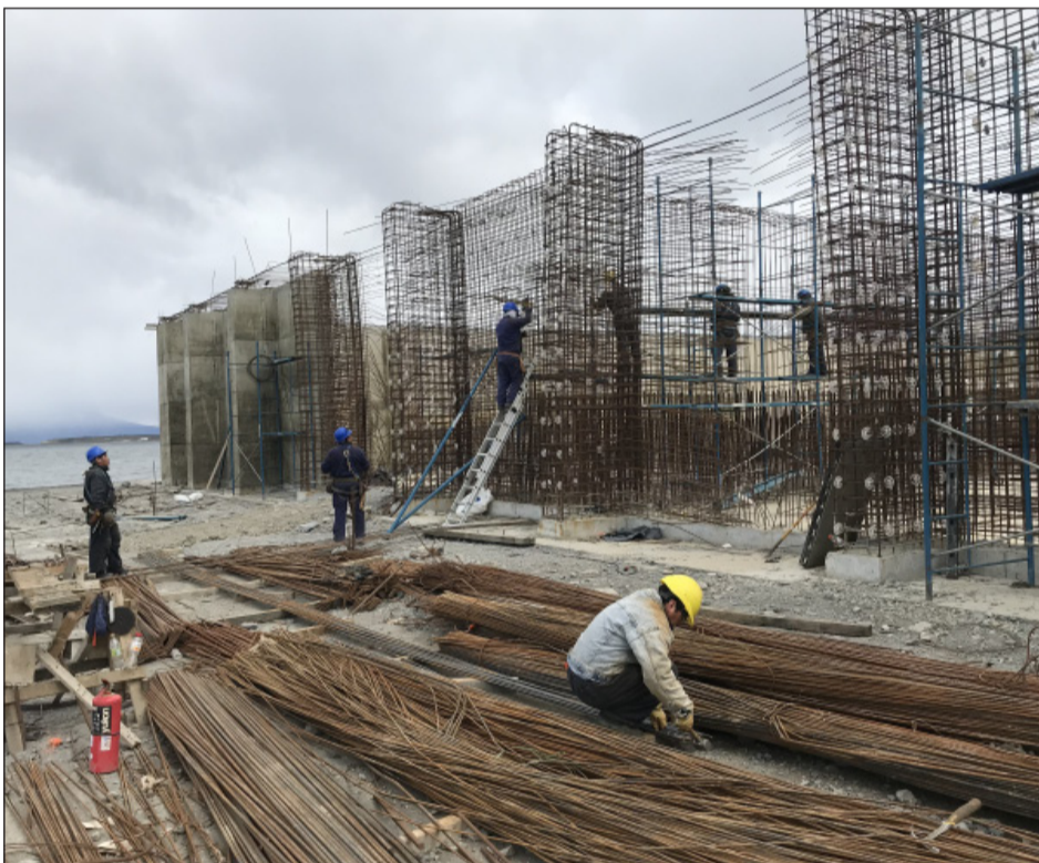
La obra de la nueva planta cloacal Arroyo Grande, en plena ejecución.
