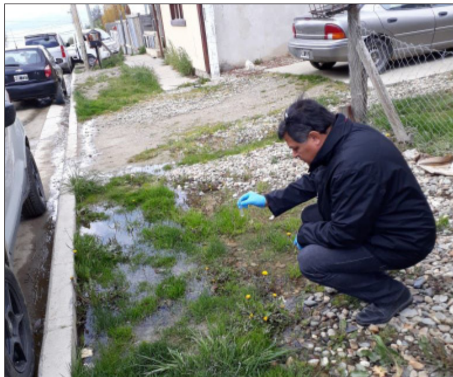
Personal de la DPOSS verifica si se trata de una pérdida de agua potable.
